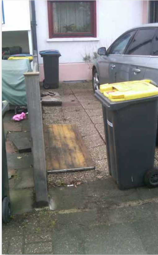
Bild 43: Absackung auf PKW-Stellfläche [Fotos: Abwasser-Service Volkner GmbH]
