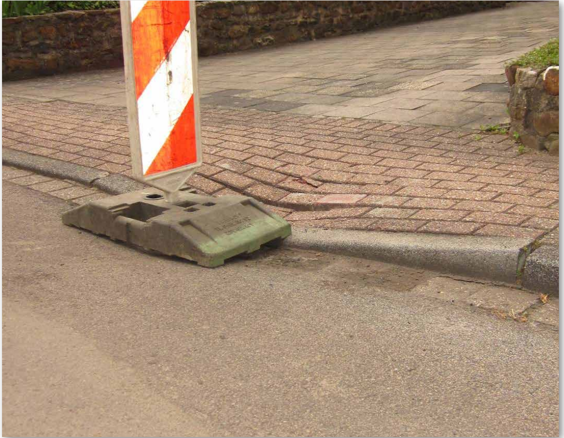
Bild 3: Absackung im Gehwegsbereich [Foto: Stadt Alsdorf]
