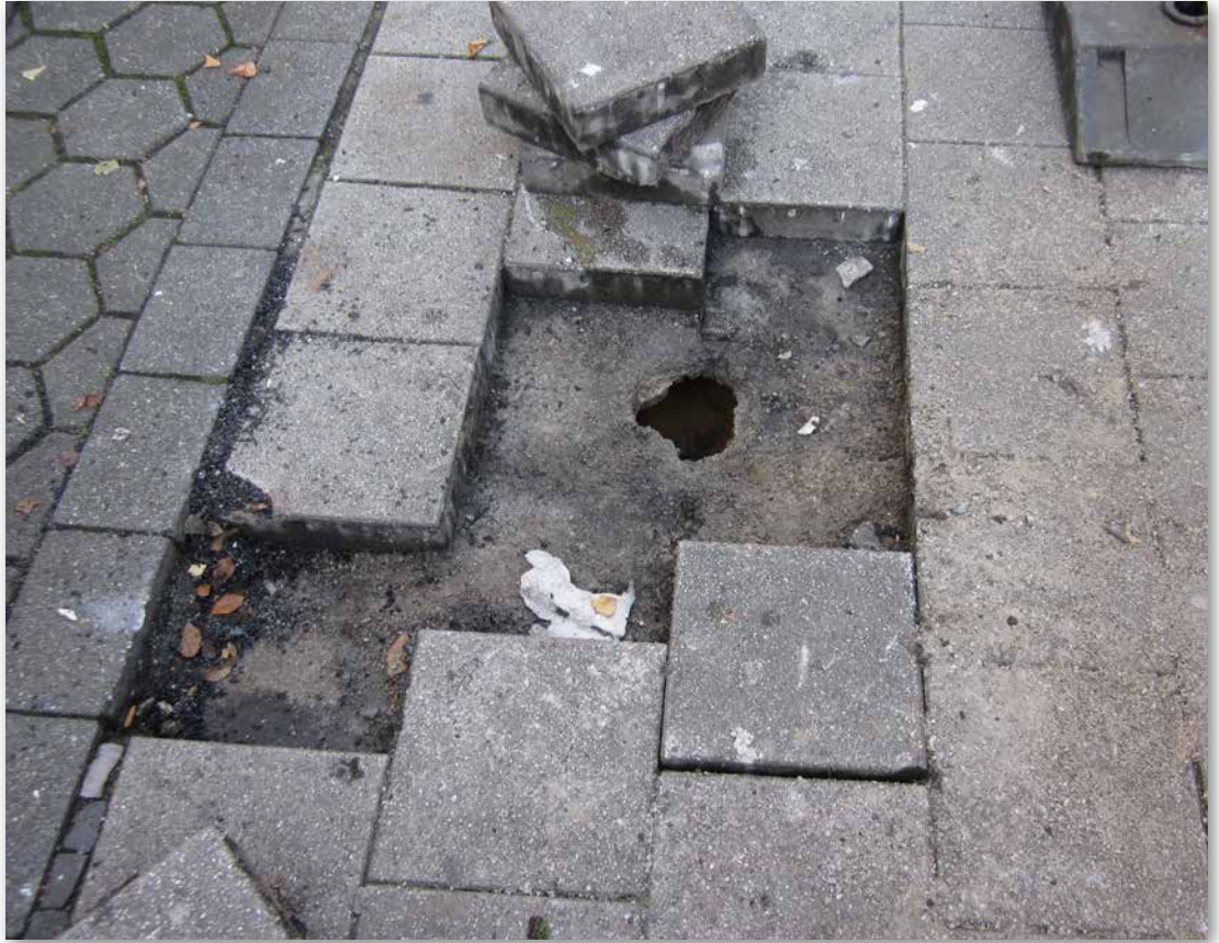
Bild 29: Straßeneinbruch im öffentlichen Verkehrsraum, Beispiel 4 [Foto: GELSENKANAL]
