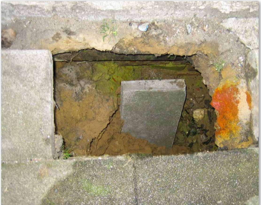
Bild 30: Straßeneinbruch im öffentlichen Verkehrsraum, Beispiel 5 [Foto: GELSENKANAL]
