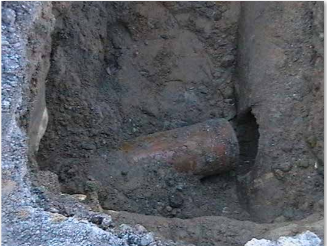
Bild 24: Freigelegte private Abwasserleitung im Bereich der Absackung aus Bild 22 – Anschluss defekt [Foto: Technische Werke Emmerich am Rhein GmbH]
