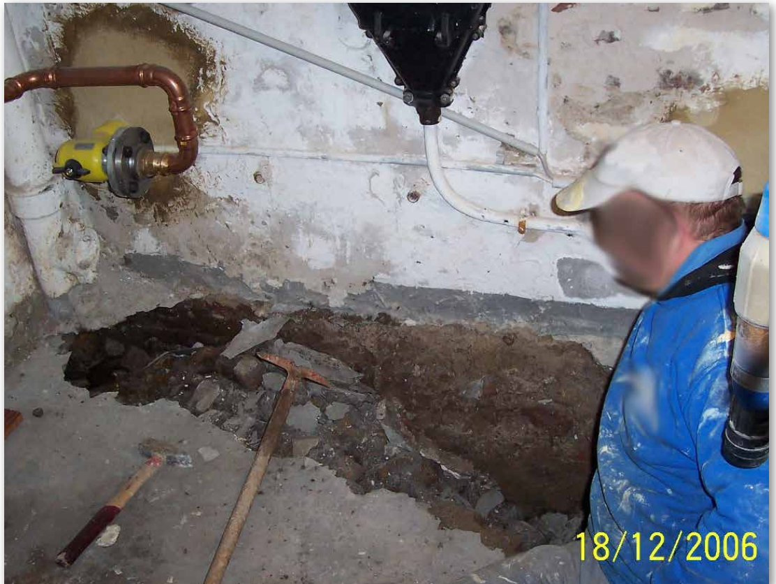
Bild 45: Bodeneinbruch im Keller eines Wohnhauses verursacht durch defekte private Abwasserleitung [Foto: Abwasser-Service Volkner GmbH]
