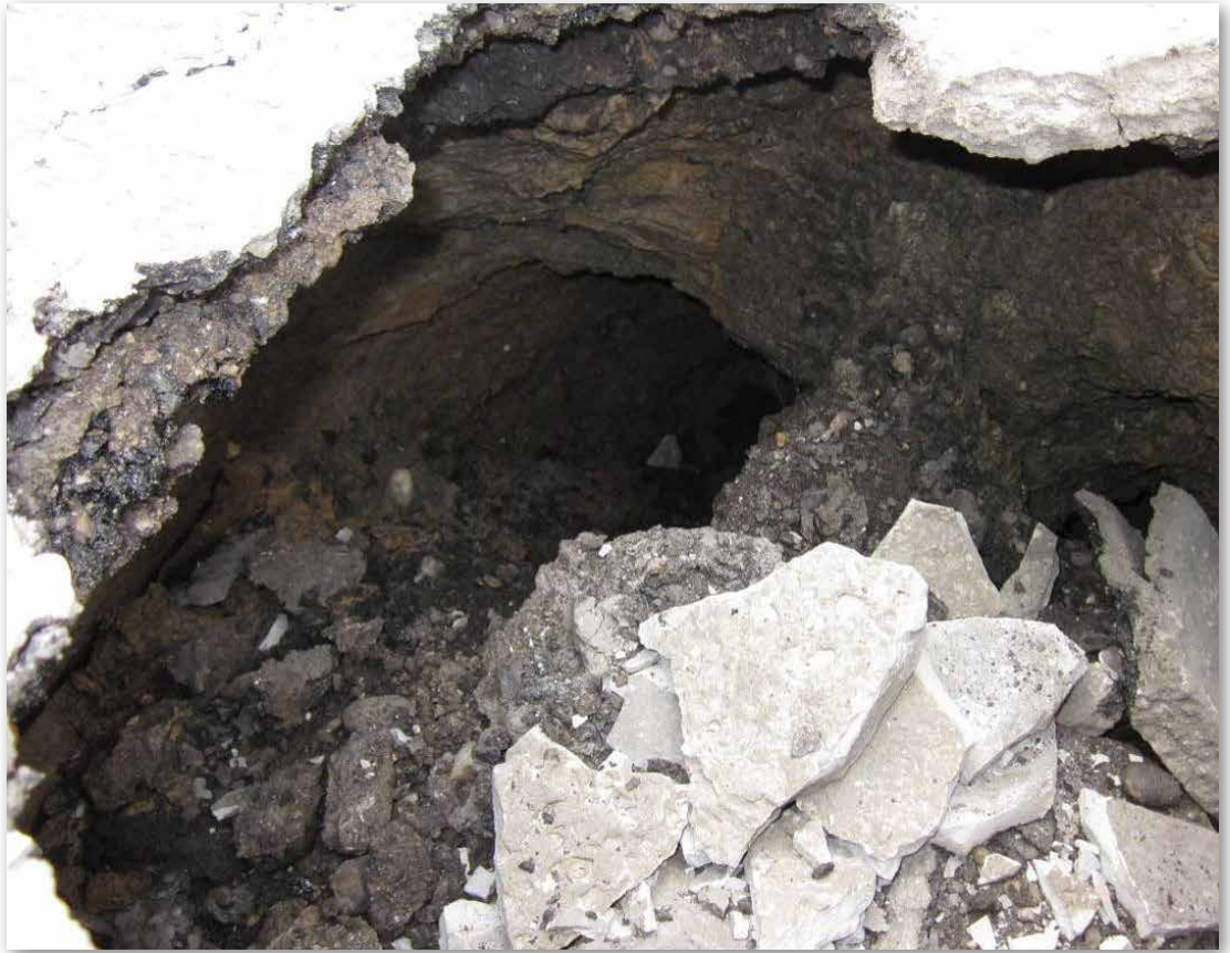
Bild 5: Hohlraum – Detailansicht zu Bild 4 [Foto: Stadt Alsdorf]
