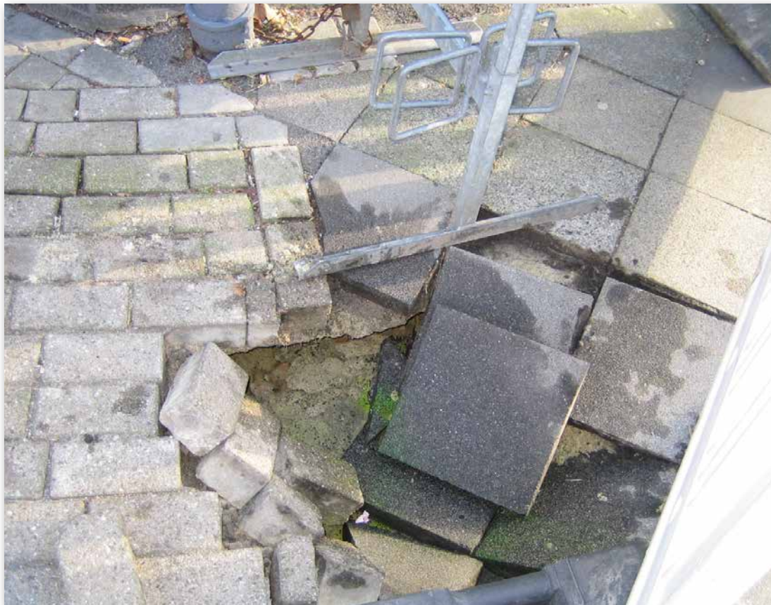
Bild 31: Straßeneinbruch im öffentlichen Verkehrsraum, Beispiel 6 [Foto: GELSENKANAL]
